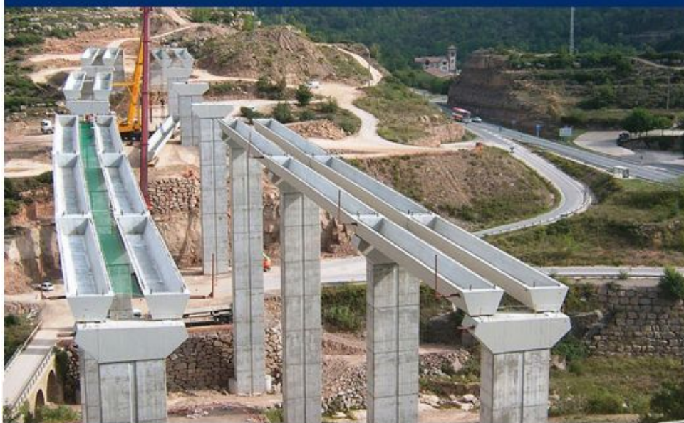
Picture of the month: Riera del Clarà Viaduct construction new Eje del Llobregat
